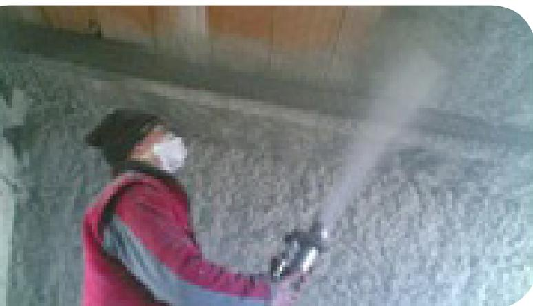
Ilustración 4. Proyectado de celulosa en paredes y techo. Rehabilitación energética de una vivienda.
