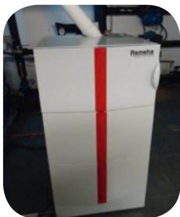
Ilustración 6. Caldera de condensación
