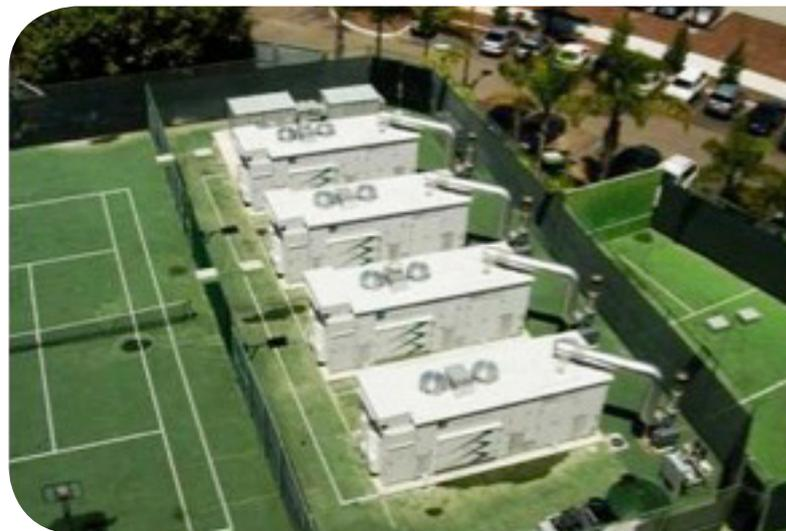
Ilustración 10. Cuatro plantas de potencia de 300 kW (DFC300) suministrando energía de manera continua en un hotel en california. Fuente: FuelCell Energy.
