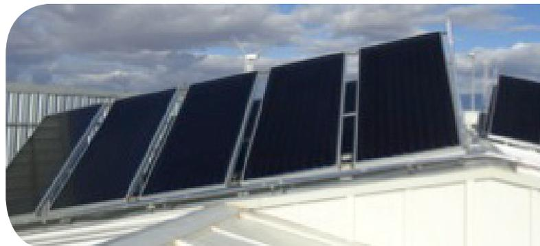
Ilustración 5. Aprovechamiento térmico de la cubierta de la FHa.
