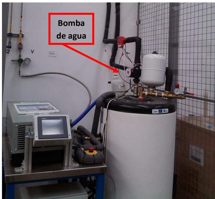
**Ilustración 54. Detalle de la instalación de la pila de cogeneración y la bomba de la calefacción**
