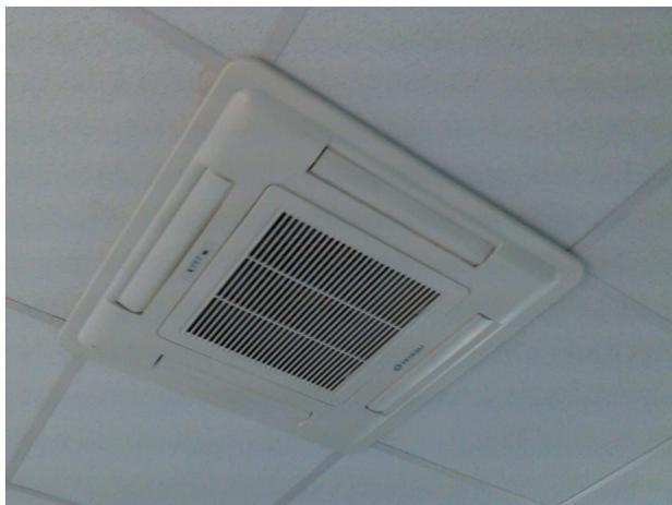
**Ilustración 53. Fancoil en el techo del laboratorio**
