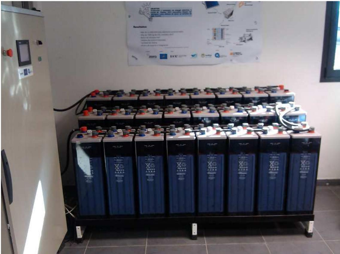
**Ilustración 14: bancada de baterías**
