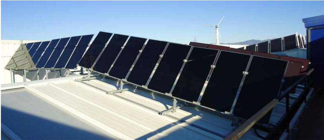
**Ilustración 11: paneles CdTe y Si amorfo en cubierta**
