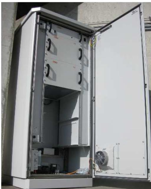
**Ilustración 9. Pila de combustible Jupiter de la empresa Future E instalada en el edificio de la Fundación del hidrógeno de Aragón**
