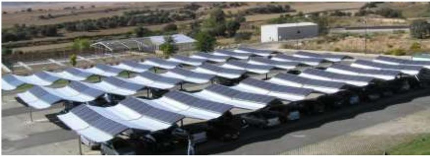
**Ilustración 3. Instalación de placa fija instalada en las marquesinas del parking.**
