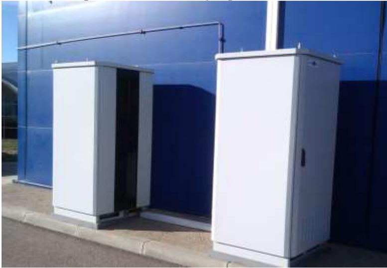
**Ilustración 20. Pilas de combustible con conexión a red**
