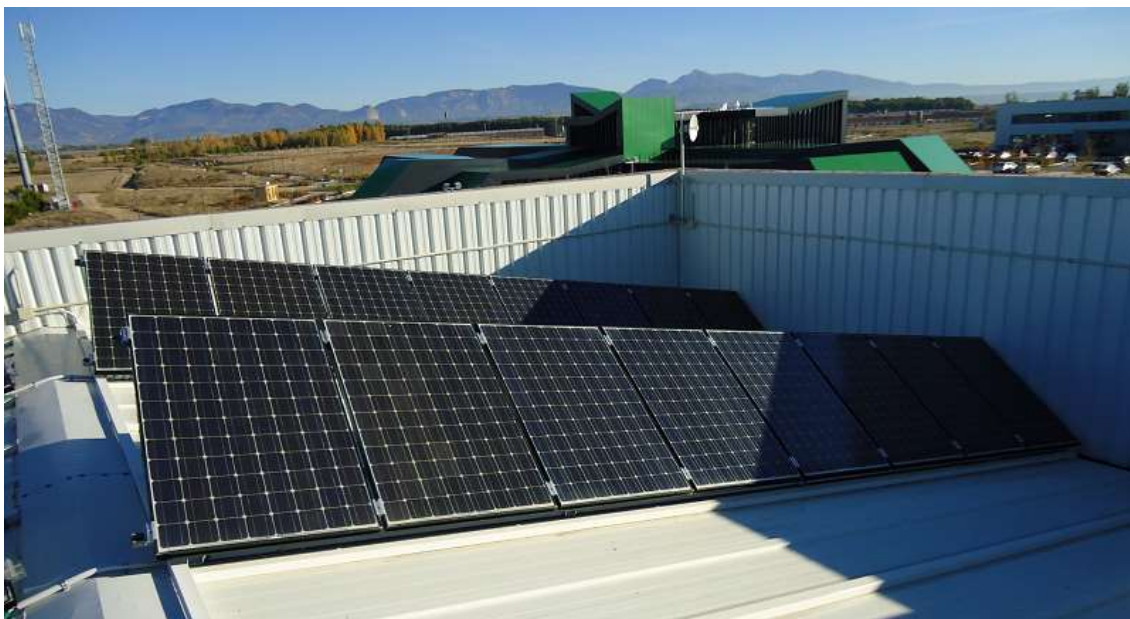
Figura 6. Paneles HIP en cubierta.
