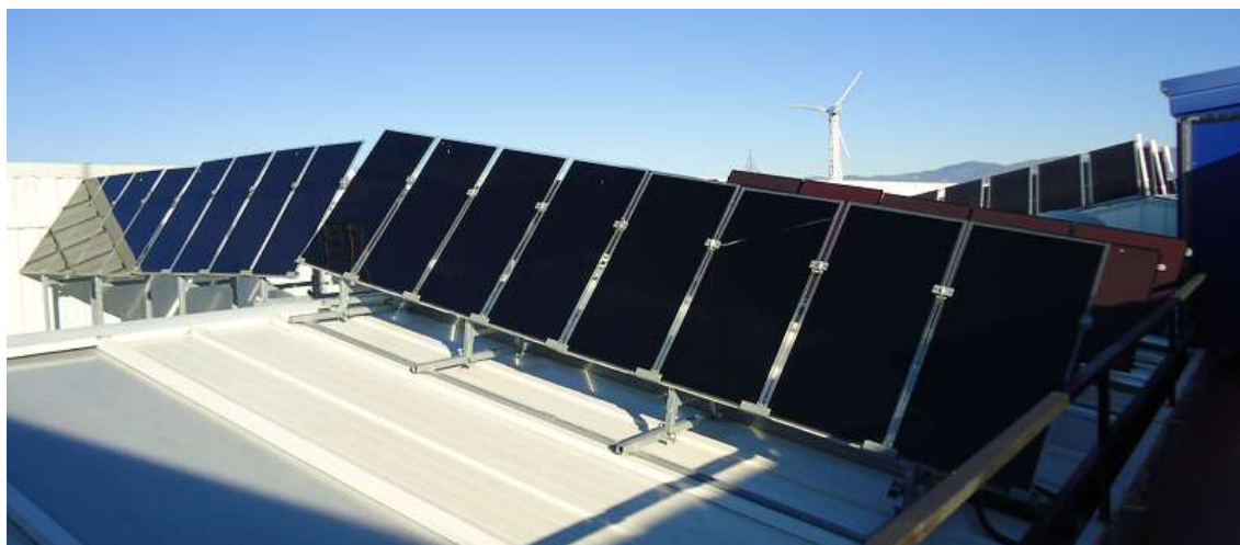
Figura 5. Paneles de CdTe y Si amorfo en la cubierta del edificio.
