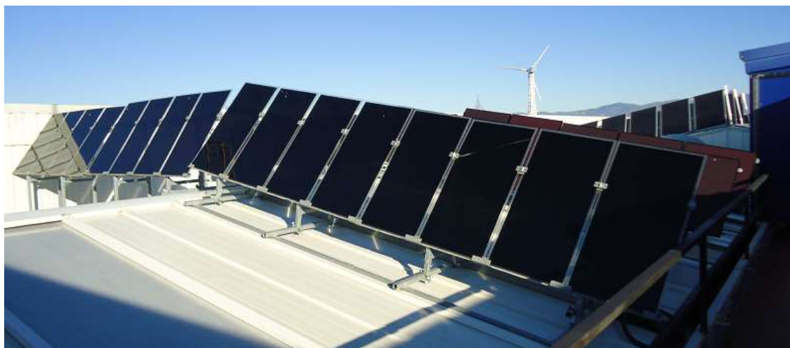
Ilustración 11: paneles CdTe y Si amorfo en cubierta
