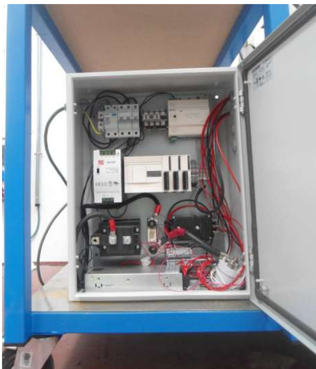
Ilustración 51. Cuadro eléctrico de la instalación
