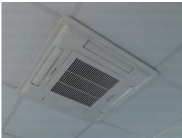
Ilustración 53. Fancoil en el techo del laboratorio
