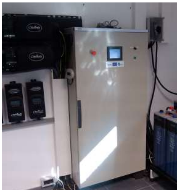
Ilustración 16: cuadro control cerrado
