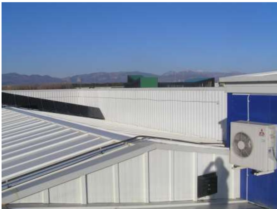
Ilustración 70. Cubierta del edificio y cuarto de calderas
