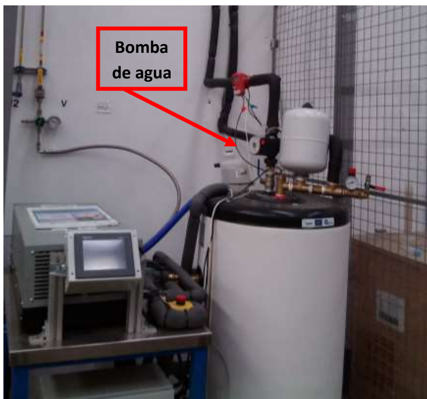
Ilustración 54. Detalle de la instalación de la pila de cogeneración y la bomba de la calefacción
