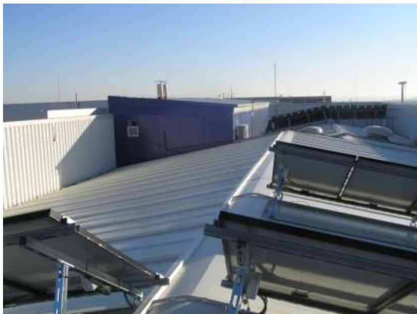
Ilustración 73. Ubicación de colectores en la cubierta del edificio
