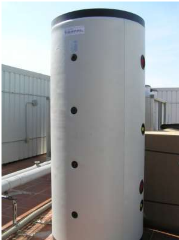
Ilustración 75. Acumulador solar de 1.000 litros
