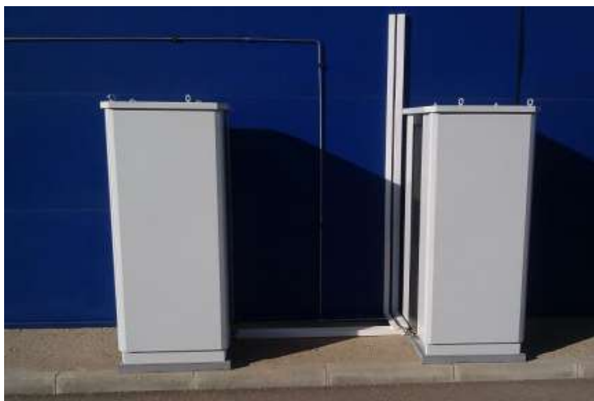
Ilustración 44. Imagen de la pila de combustible
