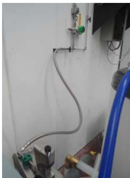
Ilustración 49. Circuito de admisión de hidrógeno
