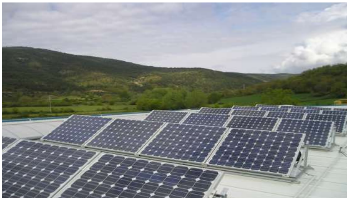
Ilustración 77. Instalación fotovoltaico en tejado
