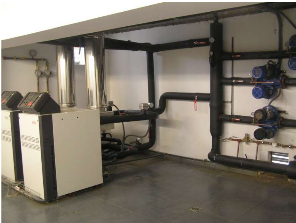
Ilustración 65. Cuarto de calderas del edificio
