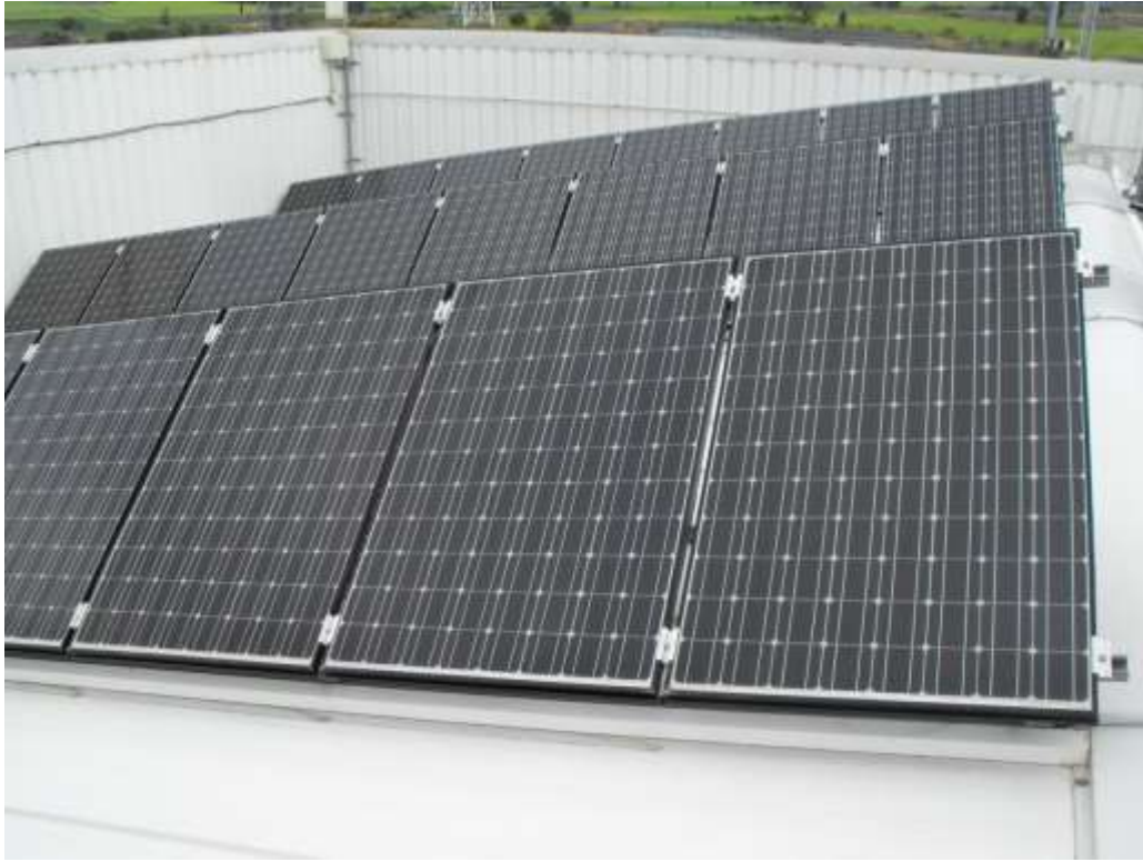
Ilustración 78. Instalación fotovoltaica en el tejado de la Fundación.
