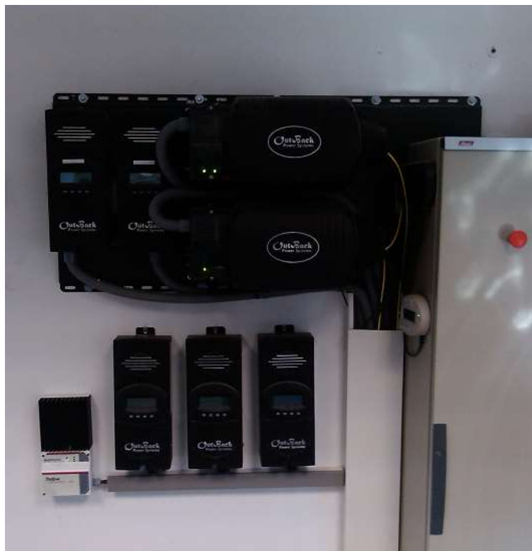
Ilustración 15: cargadores e inversores
