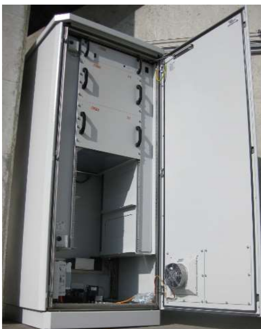
Ilustración 9. Pila de combustible Jupiter de la empresa Future E instalada en el edificio de la Fundación del hidrógeno de Aragón
