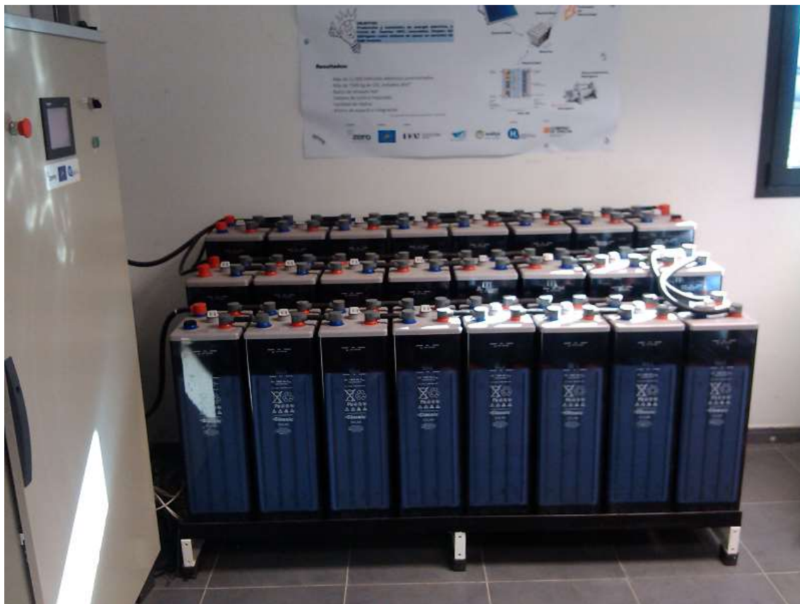
Ilustración 14: bancada de baterías
