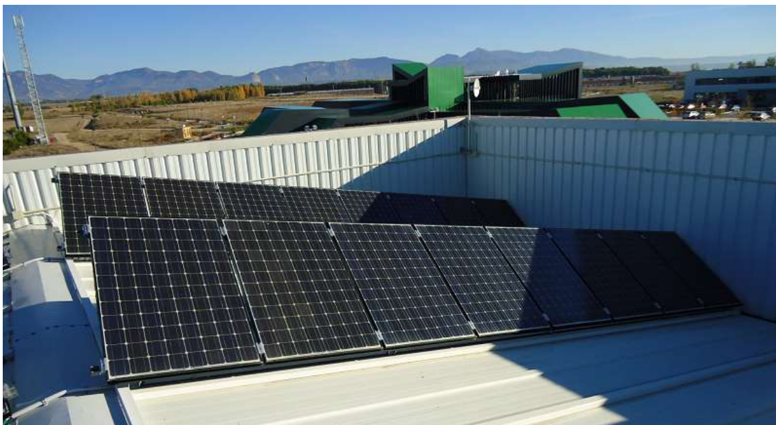
Ilustración 12: Paneles HIP en cubierta
