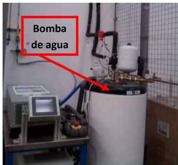
Figura 6. Detalle de la instalación de la pila de cogeneración y la bomba de la calefacción.
