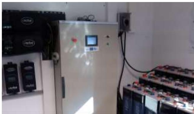
Figura 1. Baterías e inversores instalación aislada.
