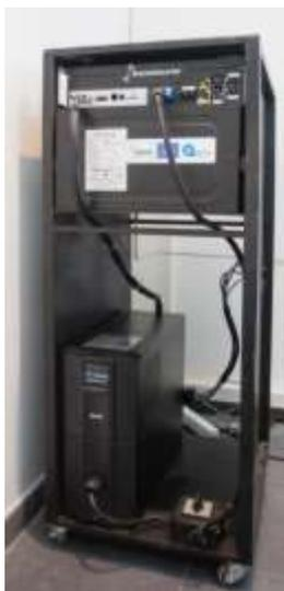
**Figura 14. SAI con pila de combustible de hidrogeno**
