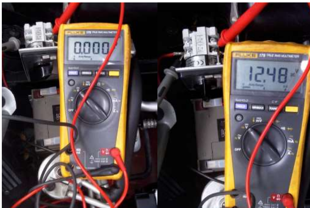
Figura 18. Tensión en las batería auxiliar (estado ON-OFF).
