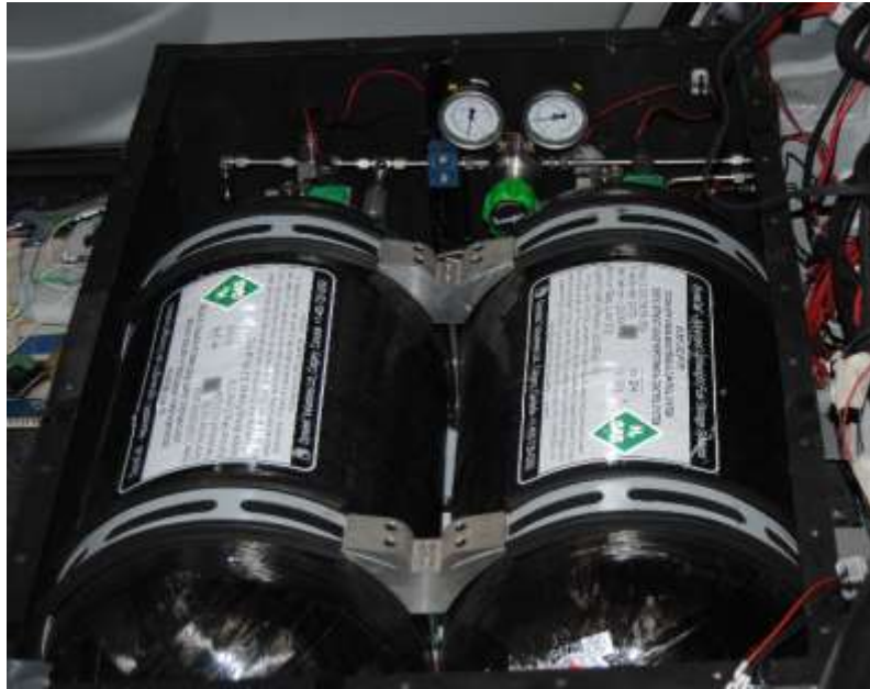
Figura 65. Depósitos de hidrógeno
