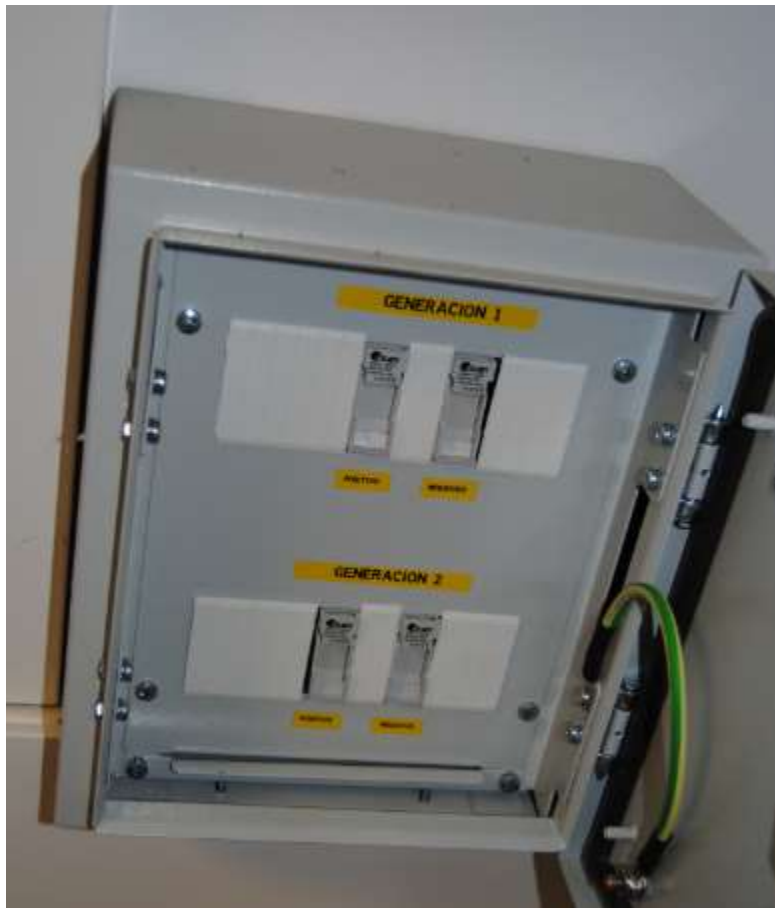
Figura 36. Caja general de protección autoconsumo
