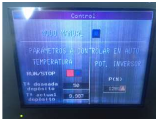
Figura 29. Modo automático donde se elige la temperatura deseada del depósito y la pila va modificando la potencia según dicha temperatura.
