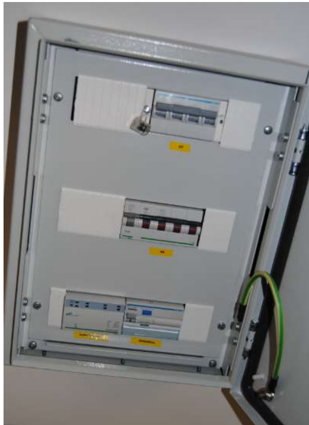
Figura 37. Caja general de protección autoconsumo
