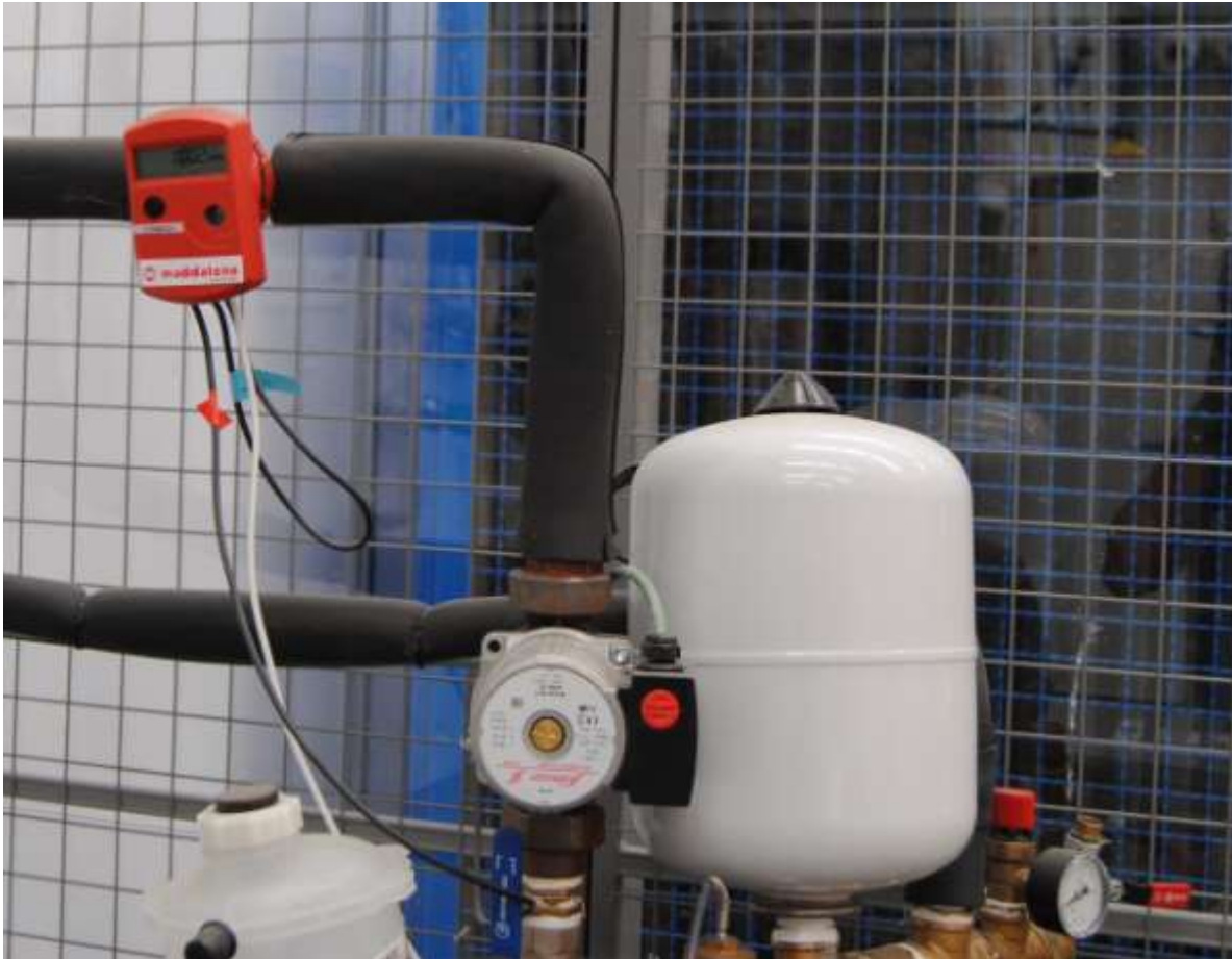
Figura 30. Caudalímetro instalado en la pila de cogeneración.
