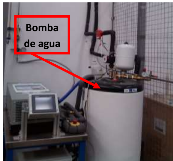
Figura 22. Detalle de la instalación de la pila de cogeneración y la bomba de la calefacción.
