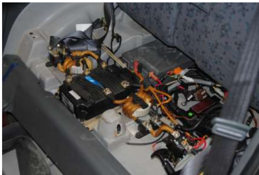
Figura 56. Control vehículo eléctrico de baterías
