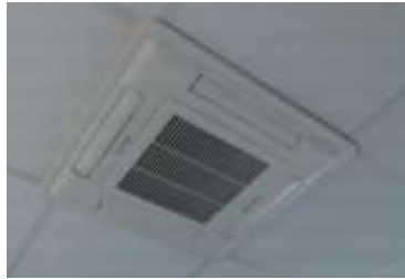
Figura 21. Fancoil en el techo del laboratorio.
