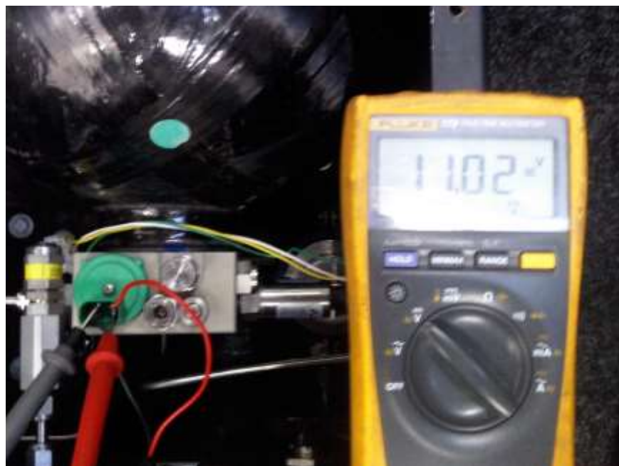
Figura 11. Electroválvula H2 (estado ON).
