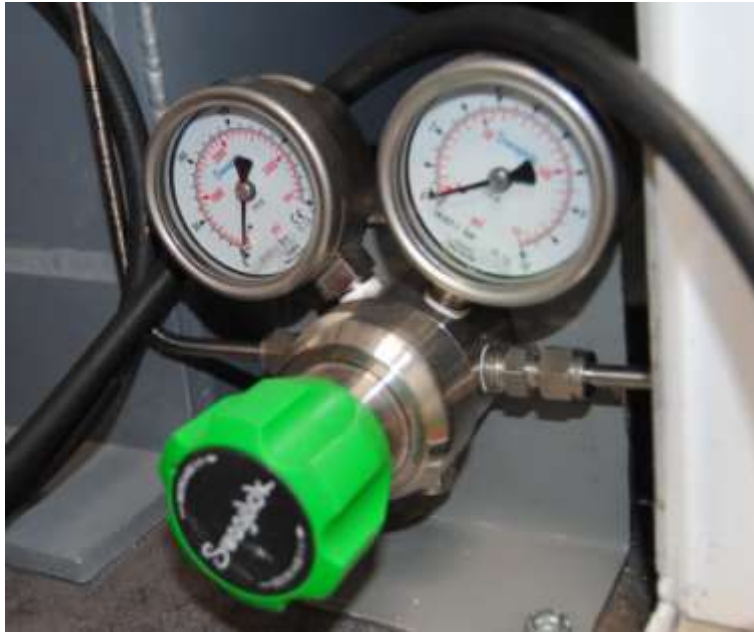
Figura 32. Regulador de presión de hidrógeno.
