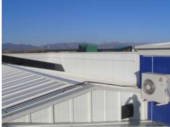
Figura 11. Cubierta del edificio y cuarto de calderas
