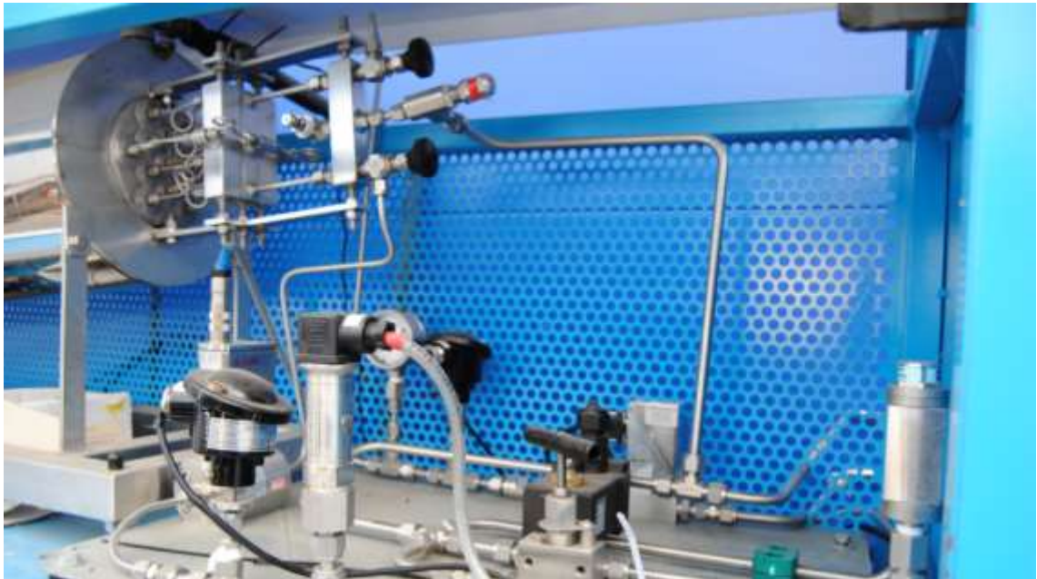
Figura 7. Instalación del Comuro.
